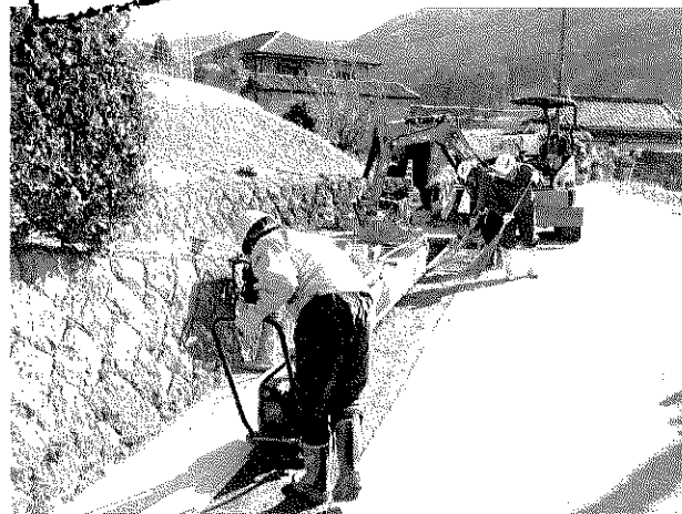
▲県道の側溝にふたをかける工事（天瀬町本城）
