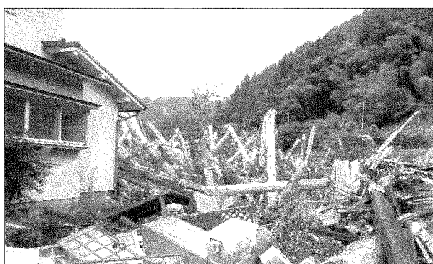
大鶴地区上宮町、住宅横の市道の橋に突き刺さった様な状態の流木
